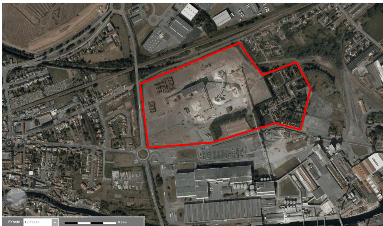
Figure n°1 : Vue aérienne du site (source : Infoterre, le 12/04/2017)
